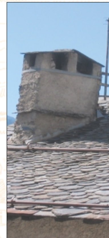
Couronnement de cheminée bâti en mitre à Sorgeat
