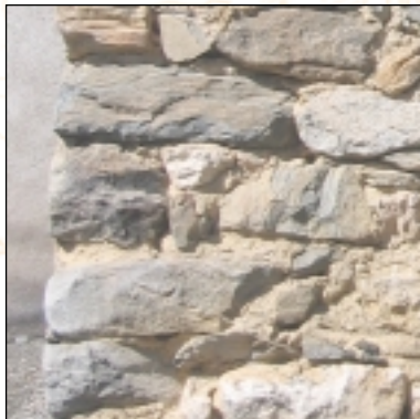
Appareillage en blocs de calcaire et calchiste à Bestiac (à gauche) et à Goulours (à droite)
