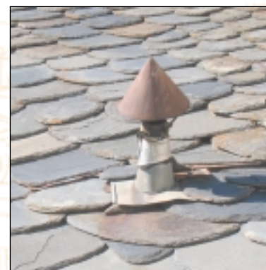
Sortie de poêle sur toiture ardoise, Mijanes
