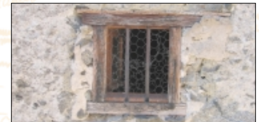
Fenêtre de grange à Mijanès
