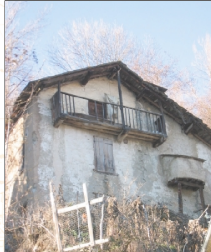
Façade avec balcon et four à pain en encorbellement à Lapège
