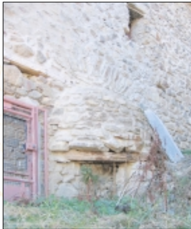
Four à pain reposant sur le sol à Lapège
