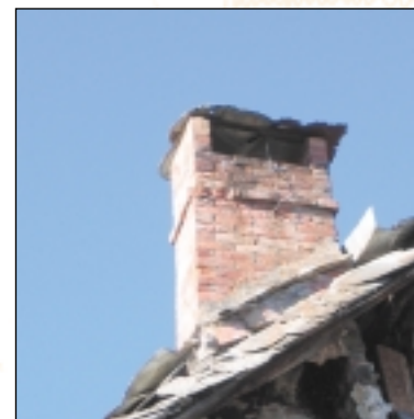
Souche de cheminée en brique couronnée par une tôle, Lapège
