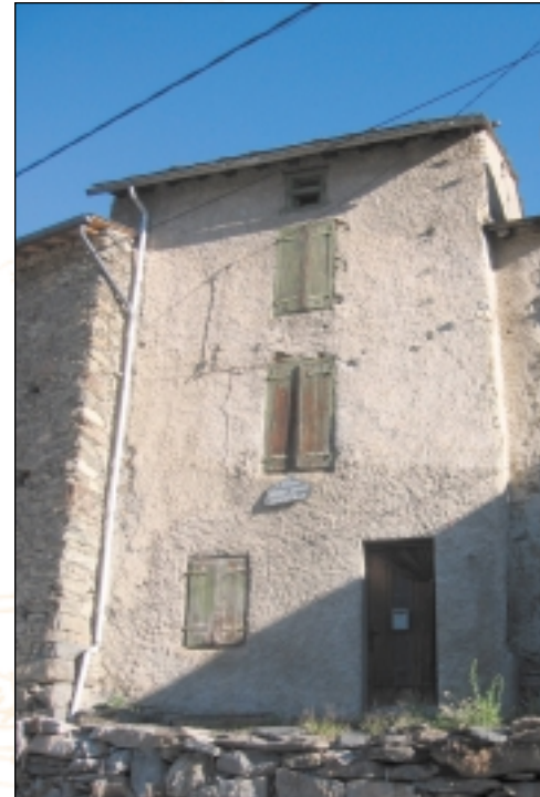
Enduit d'origine à la chaux qui ne met pas en péril les qualités d'imperméabilité du mur et peut donc être conservé.
