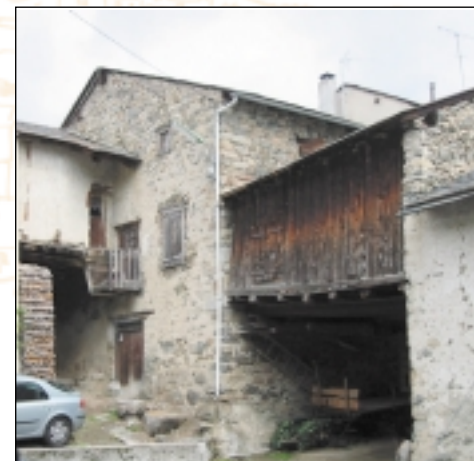
Bardage d'un grenier à Artigue où le bois a été utilisé pour sa légèreté et permettre ainsi la création d'un passage ouvert sous le grenier.
