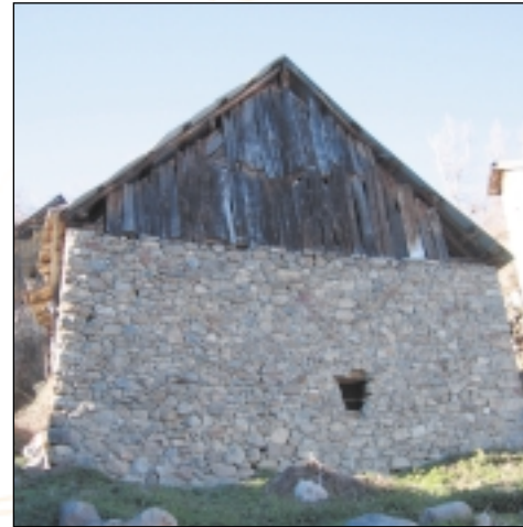
Bardage vertical en planches de bois, à droite, clayonnage de branches de noisetier, à Lapège
