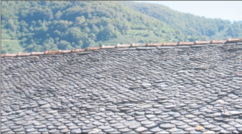
Toiture en ardoises avec faîtage en tuile romane à Bestiac
