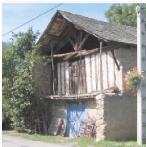
Banat, ossature à pans de bois sur la partie fenil de la grange, protégée par l'avancée du toit
