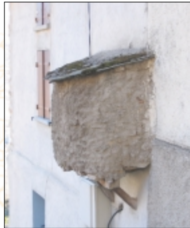
Four à pain en encorbellement à Lapège
