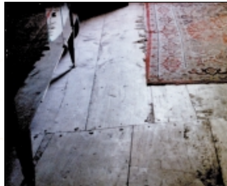
Plancher intérieur réalisé avec de larges planches clouées sur poutres et solives.
